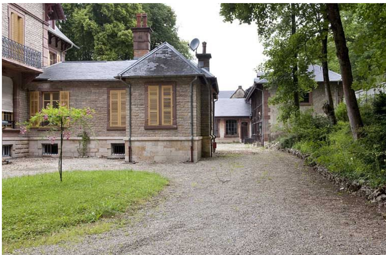
Façade sud de l'annexe et communs.
