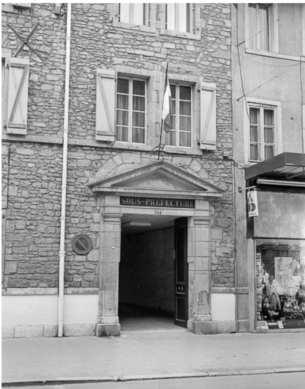
Le portail d'entrée du couvent.
