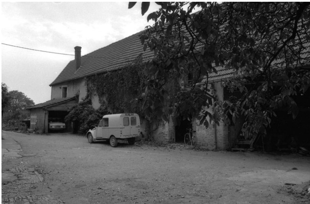
Bâtiment de droite : façade sur cour.
