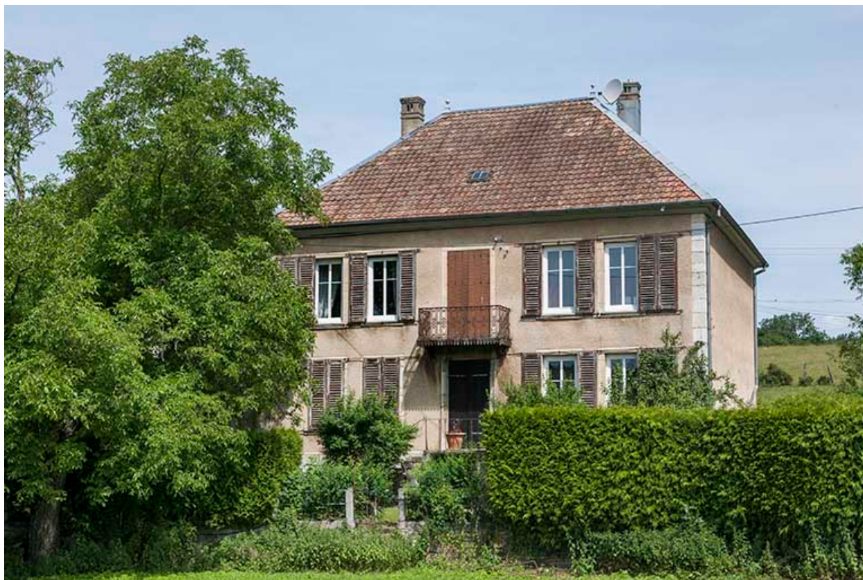
Façade sud du logement.
