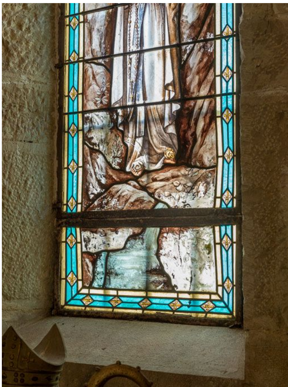
Vitrail : détail de la déformation et de l'altération des couleurs.
