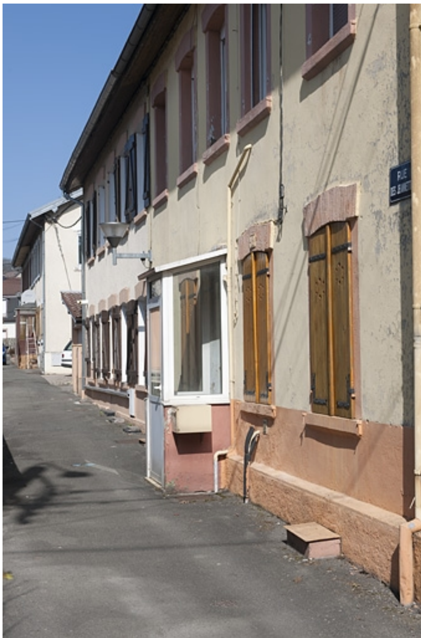
Détail d'une façade d'une habitations à 8 logements.
