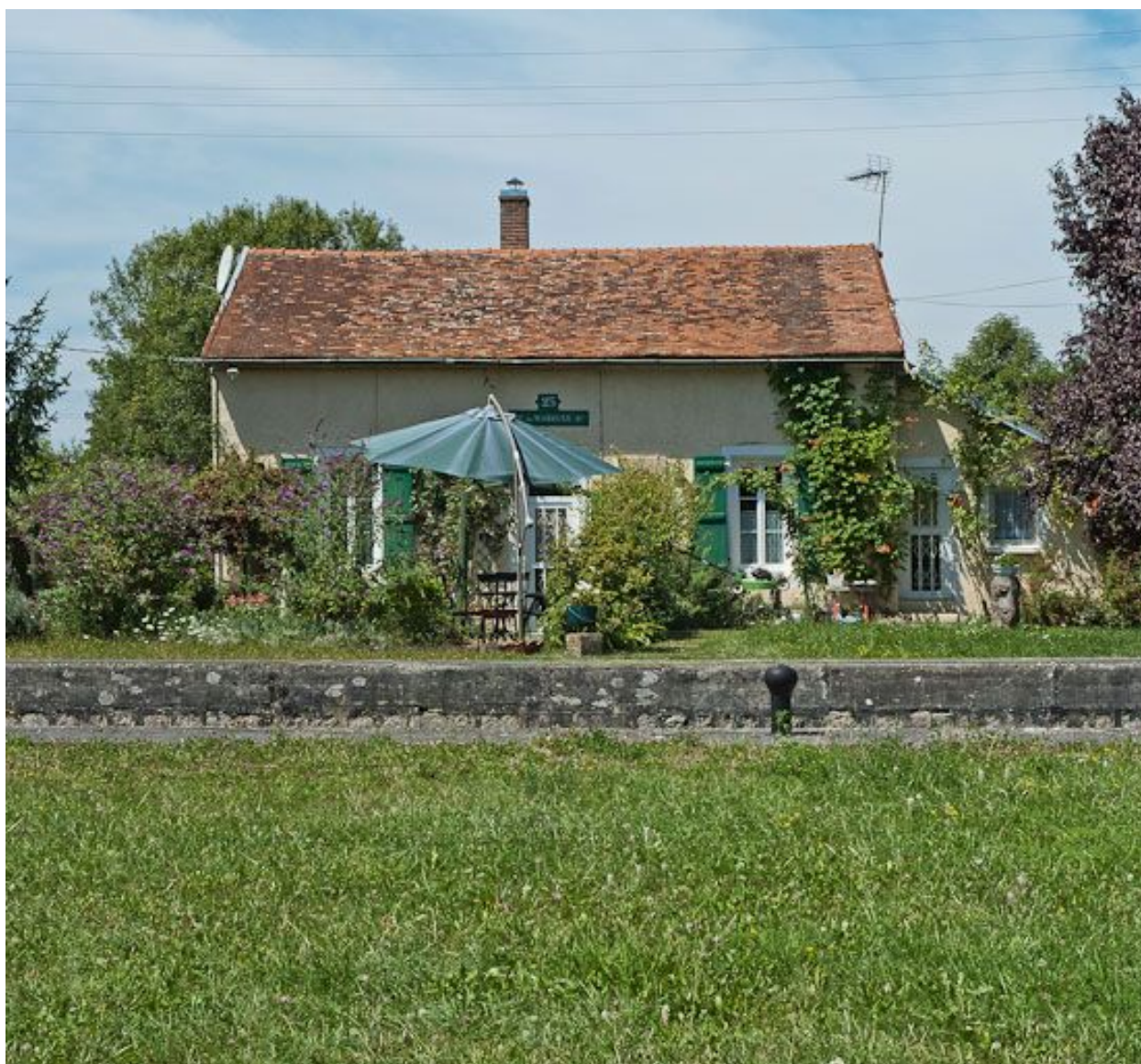
Vue de face de la maison éclusière.
