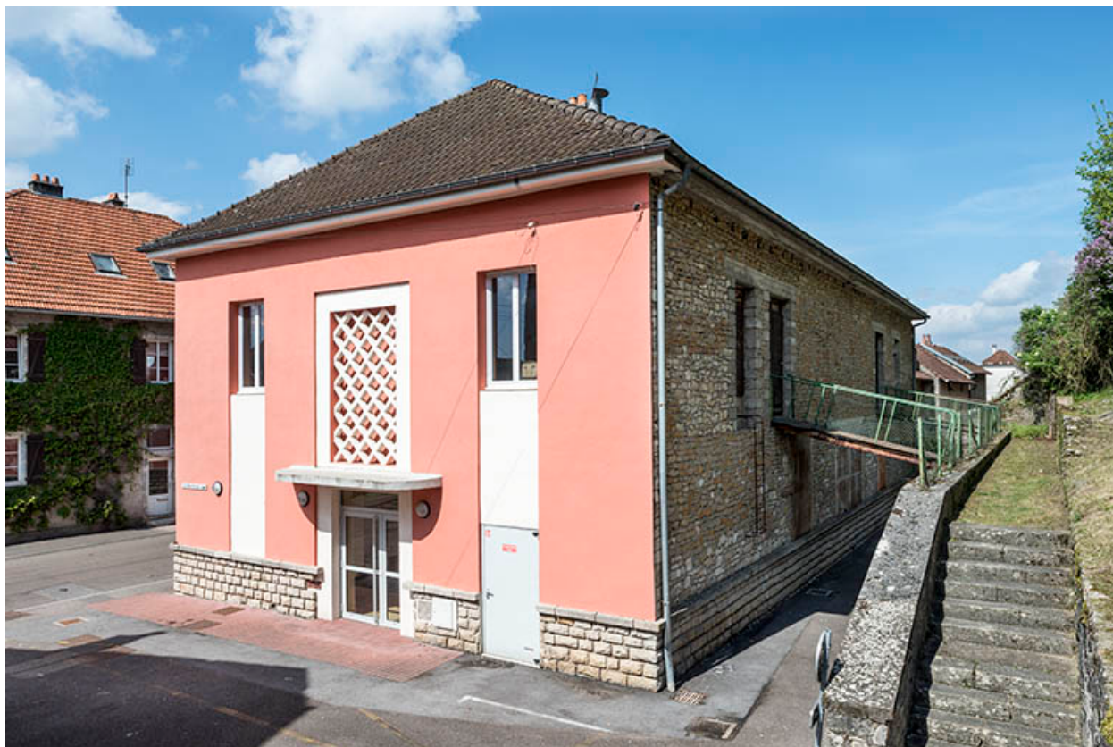
Le mur pignon sud.
