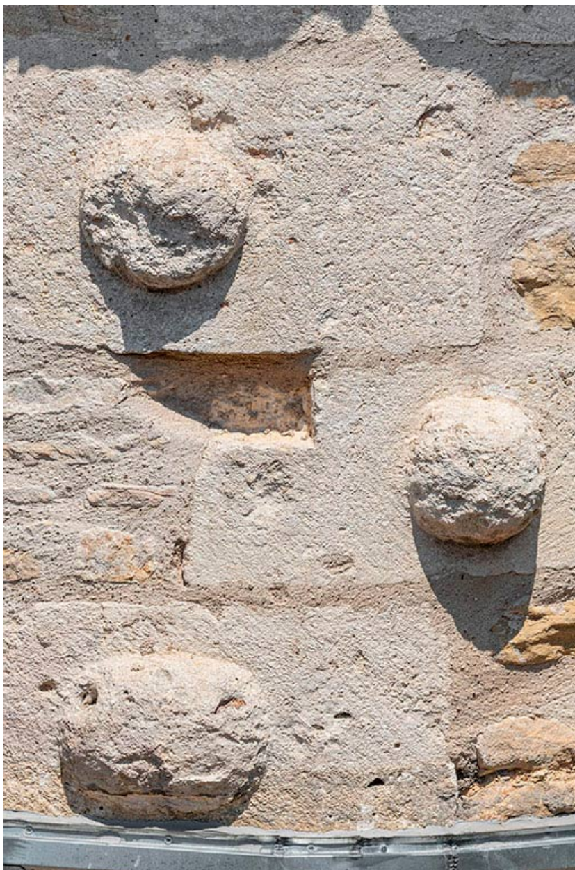
Bossage au niveau de la plateforme.
