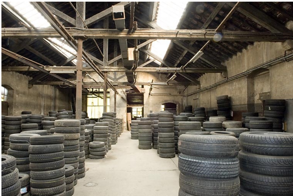
Charpente et couverture de l'atelier de fabrication.
