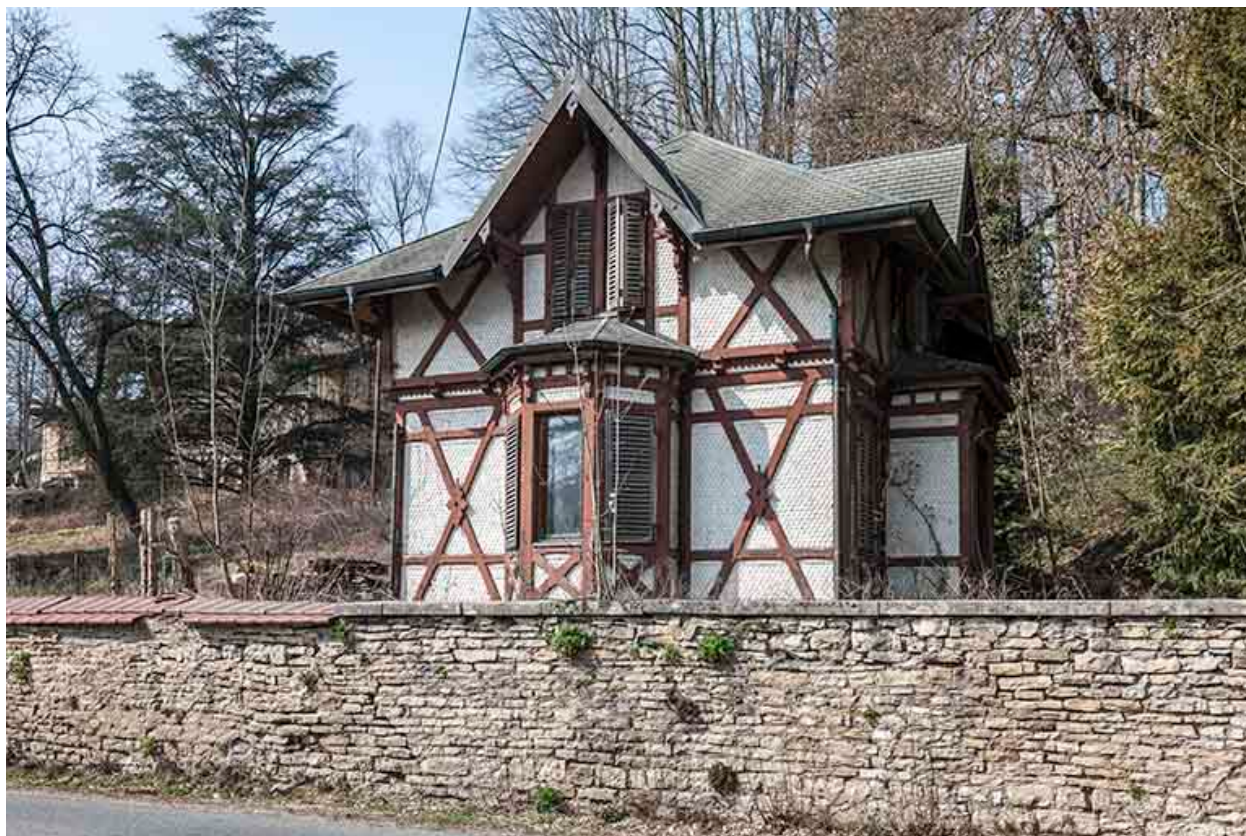
Façade sud de la conciergerie.
