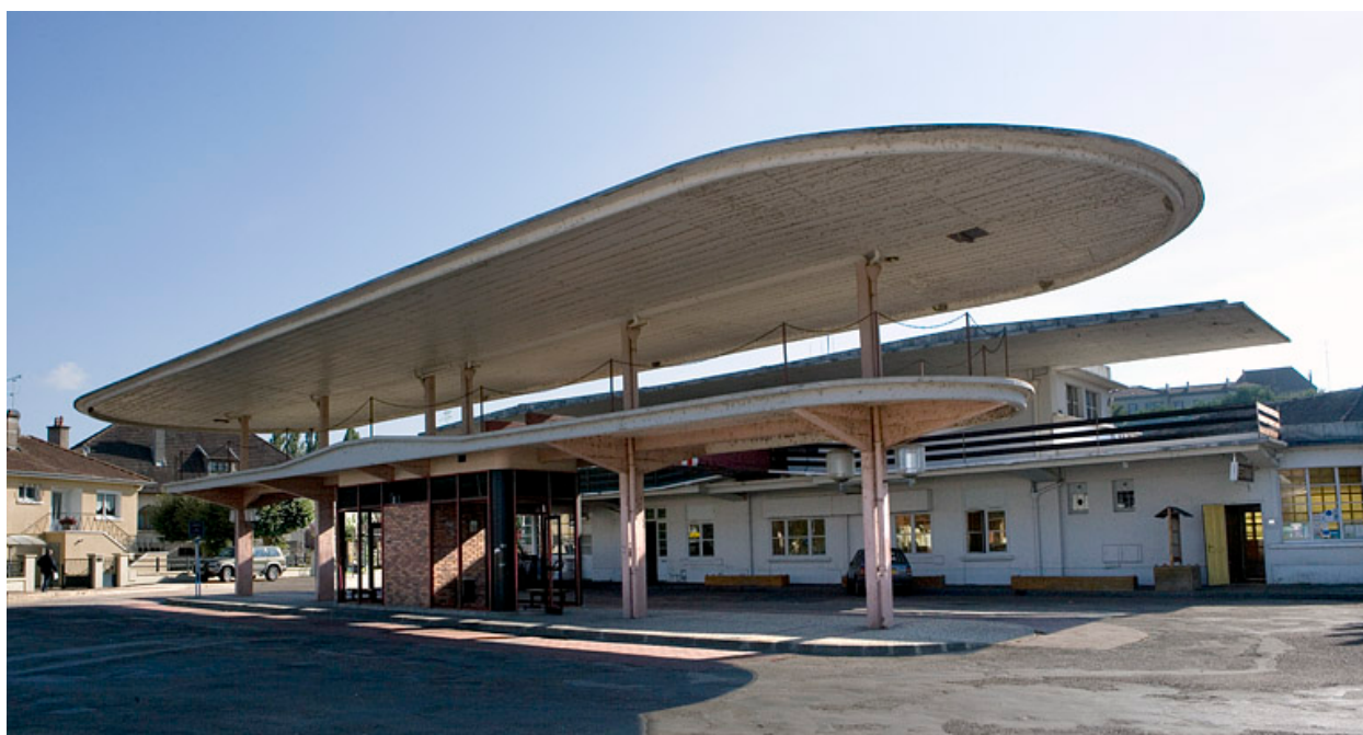
Station bus avec auvents.
