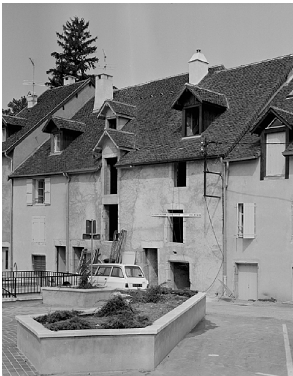
Façade antérieure avant réfection de l'enduit.
