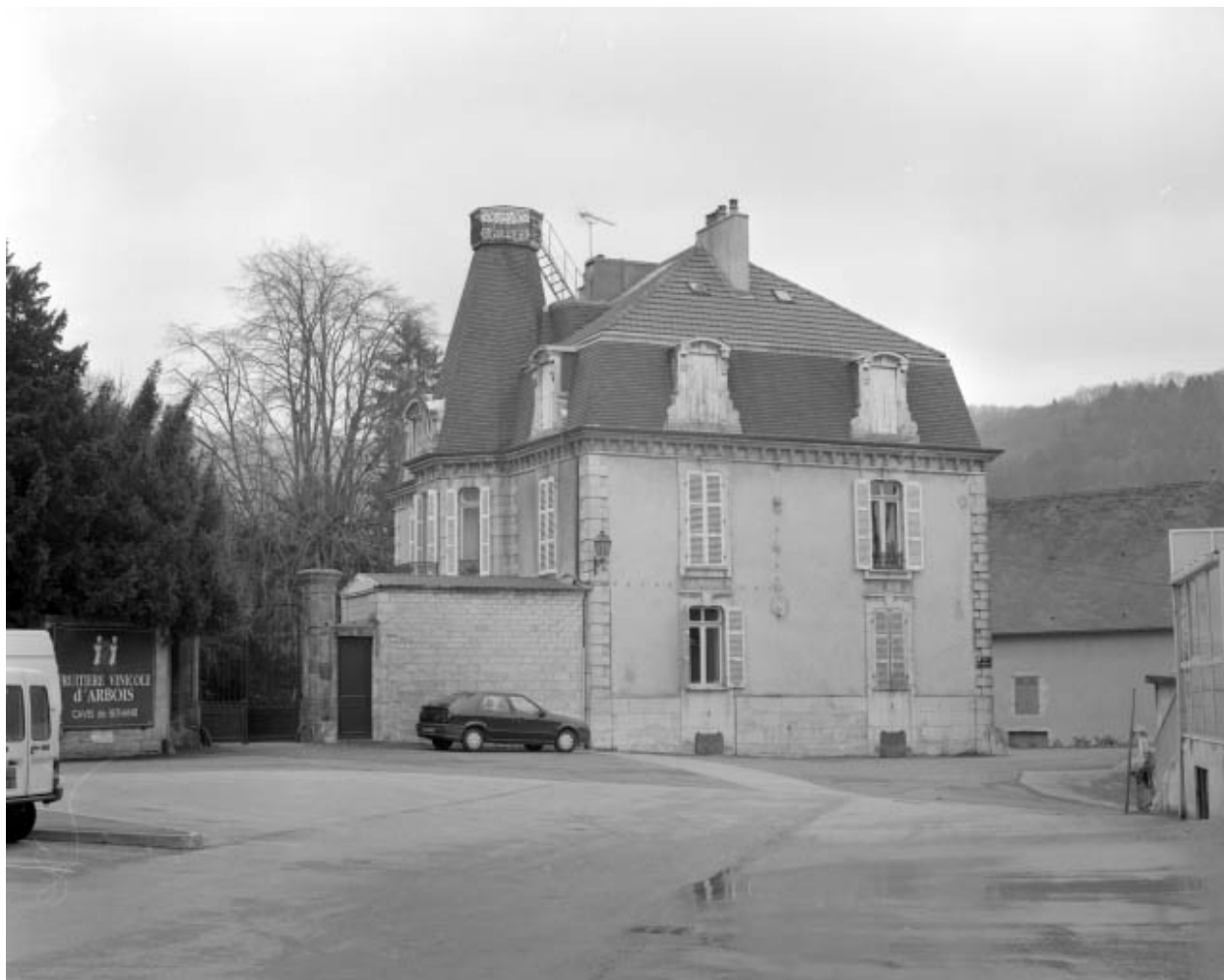
Façade latérale du château Béthanie.
