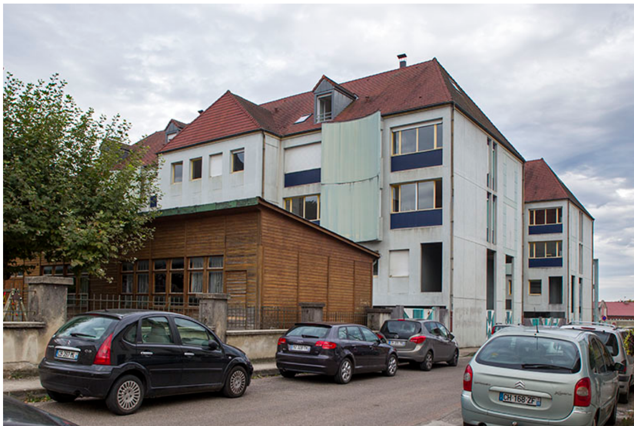
Internat : façades arrière.
