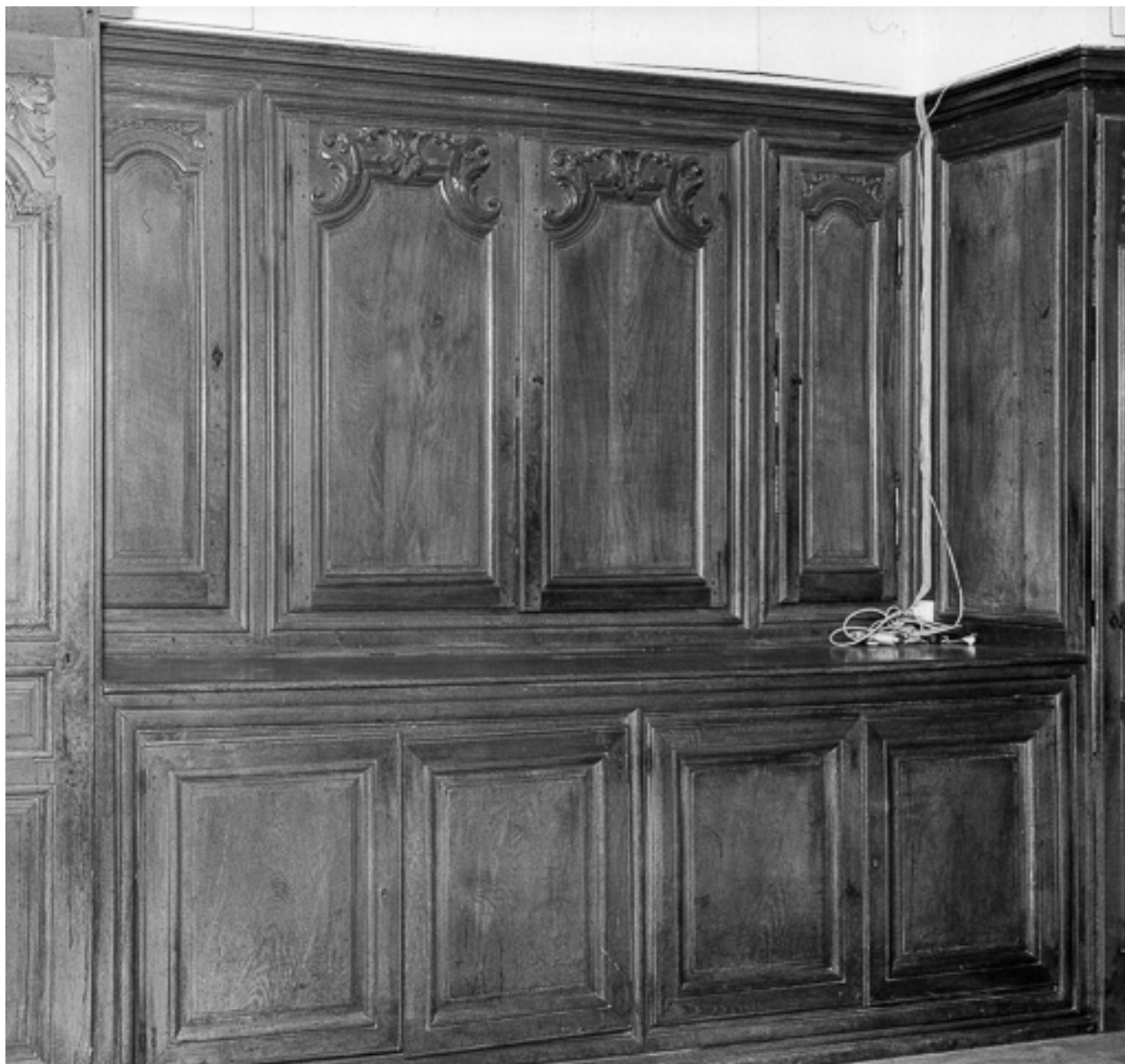
Lambris du mur ouest de la sacristie.
