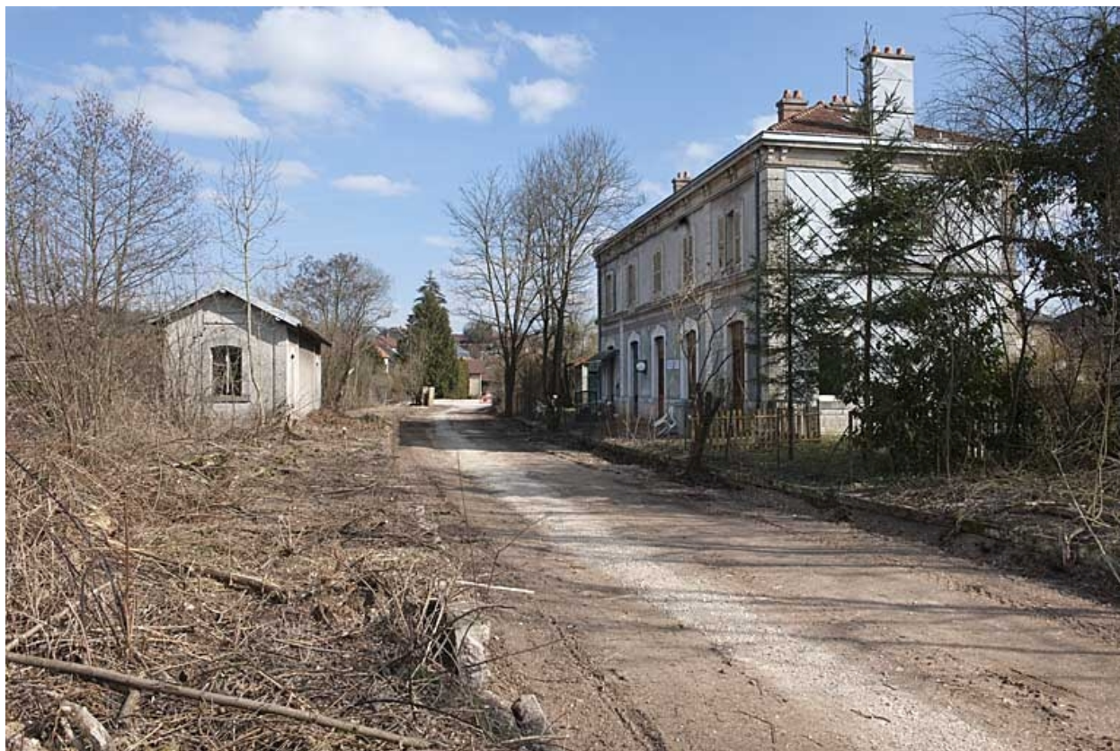
Bâtiment des voyageurs et abri.
