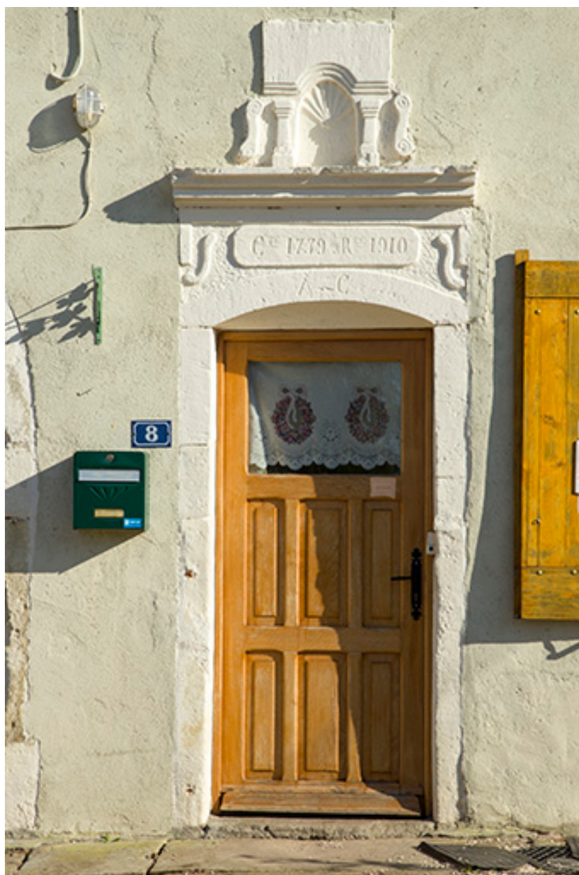
Détail d'une porte, rue Royale.
