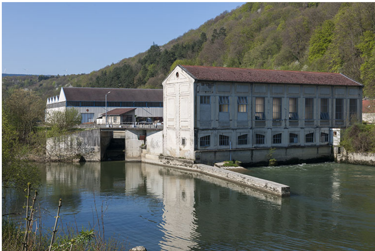
Vue d'ensemble du site depuis le nord-est.
