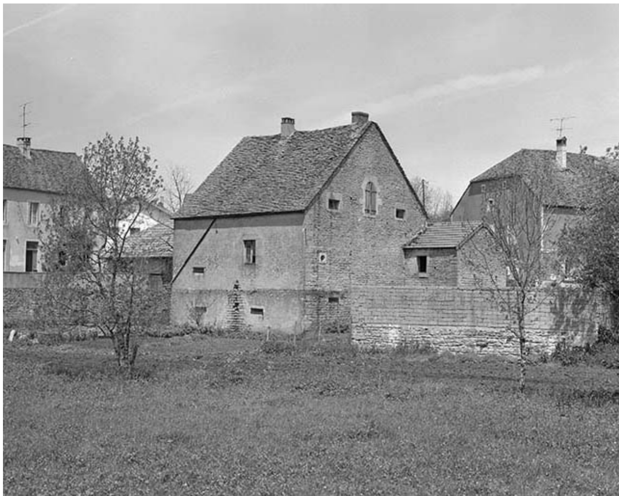
Façade postérieure et façade gauche en 1981.
