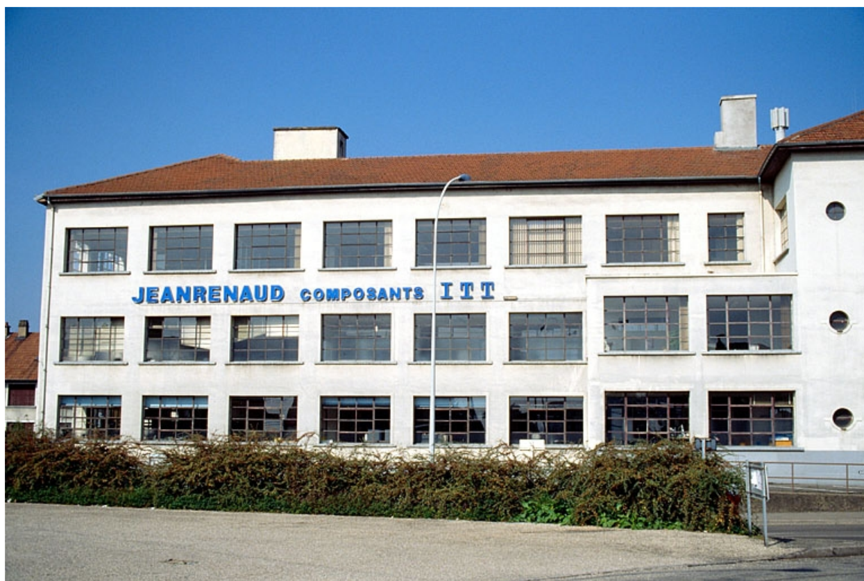
Usine 1 : façade antérieure de l'aile (B).
