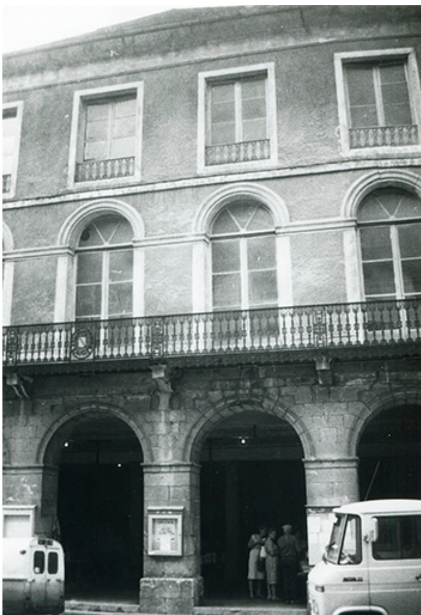
Détail de la façade antérieure, 1982.
