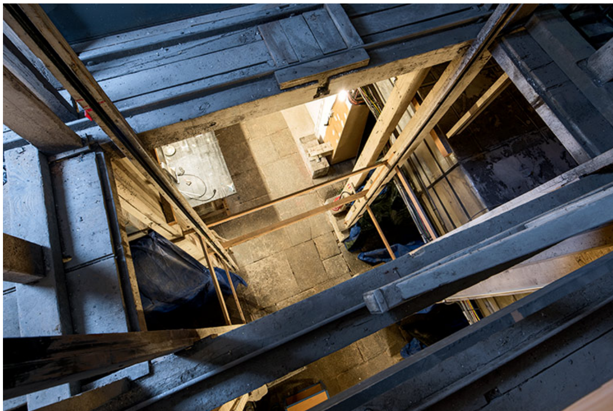
1er dessous : trappe de monte-charge, montrant le 2e dessous.
