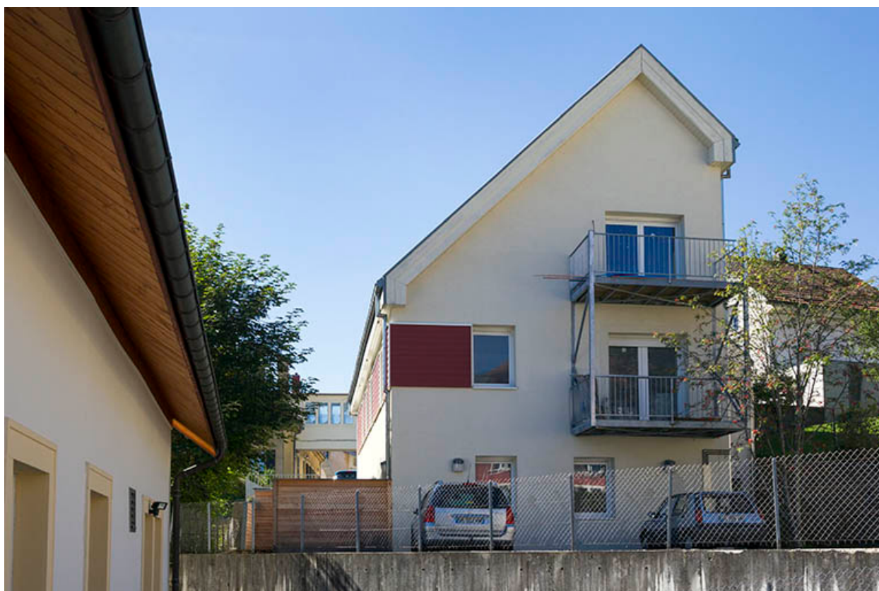
Façade nord du troisième corps de bâtiment.
