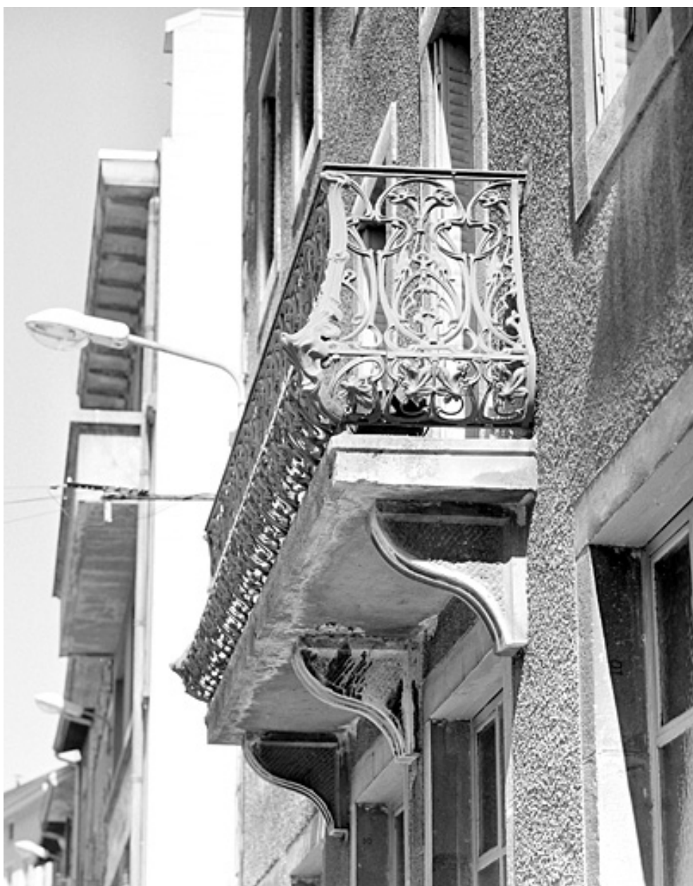
Balcon de l'immeuble, de profil.
