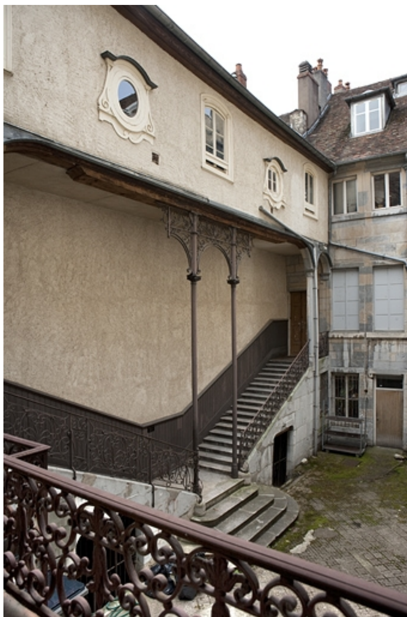
Escalier à cage ouverte
