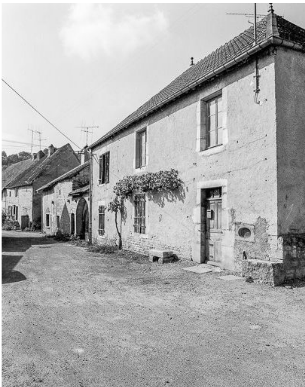
Façade antérieure de l'habitation.
