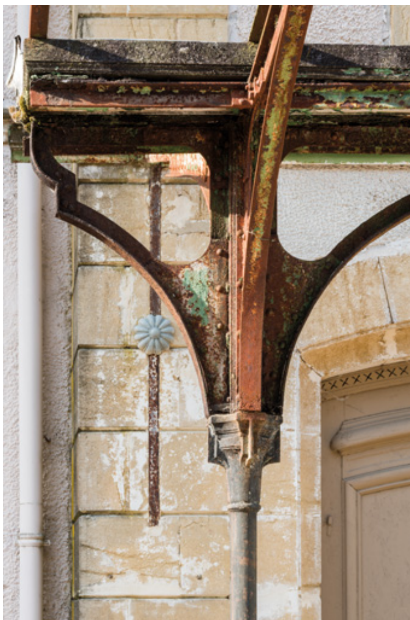
Marquise de la façade sur l'avenue, détail.
