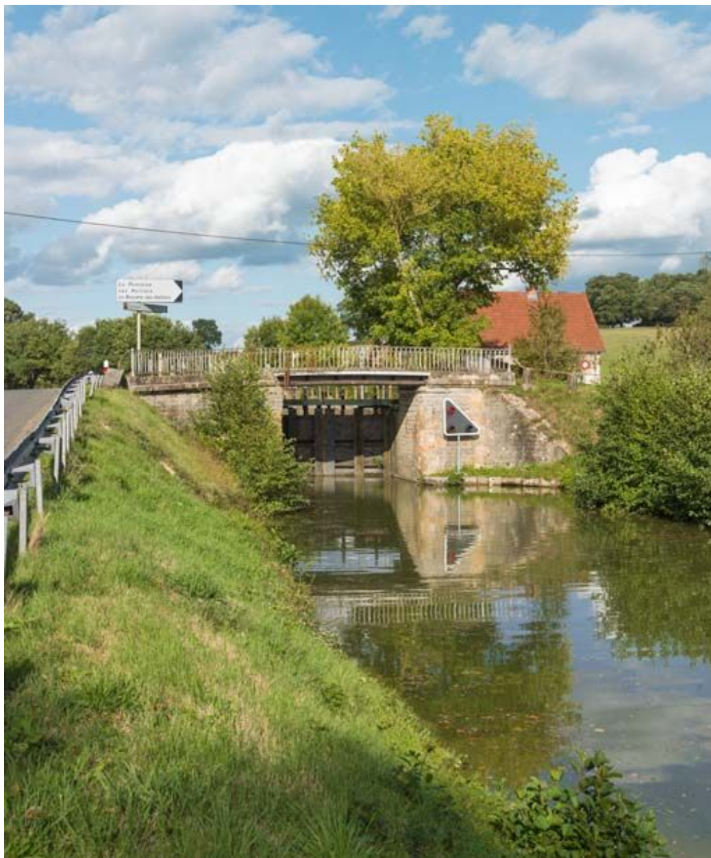
Vue d'ensemble du pont.
