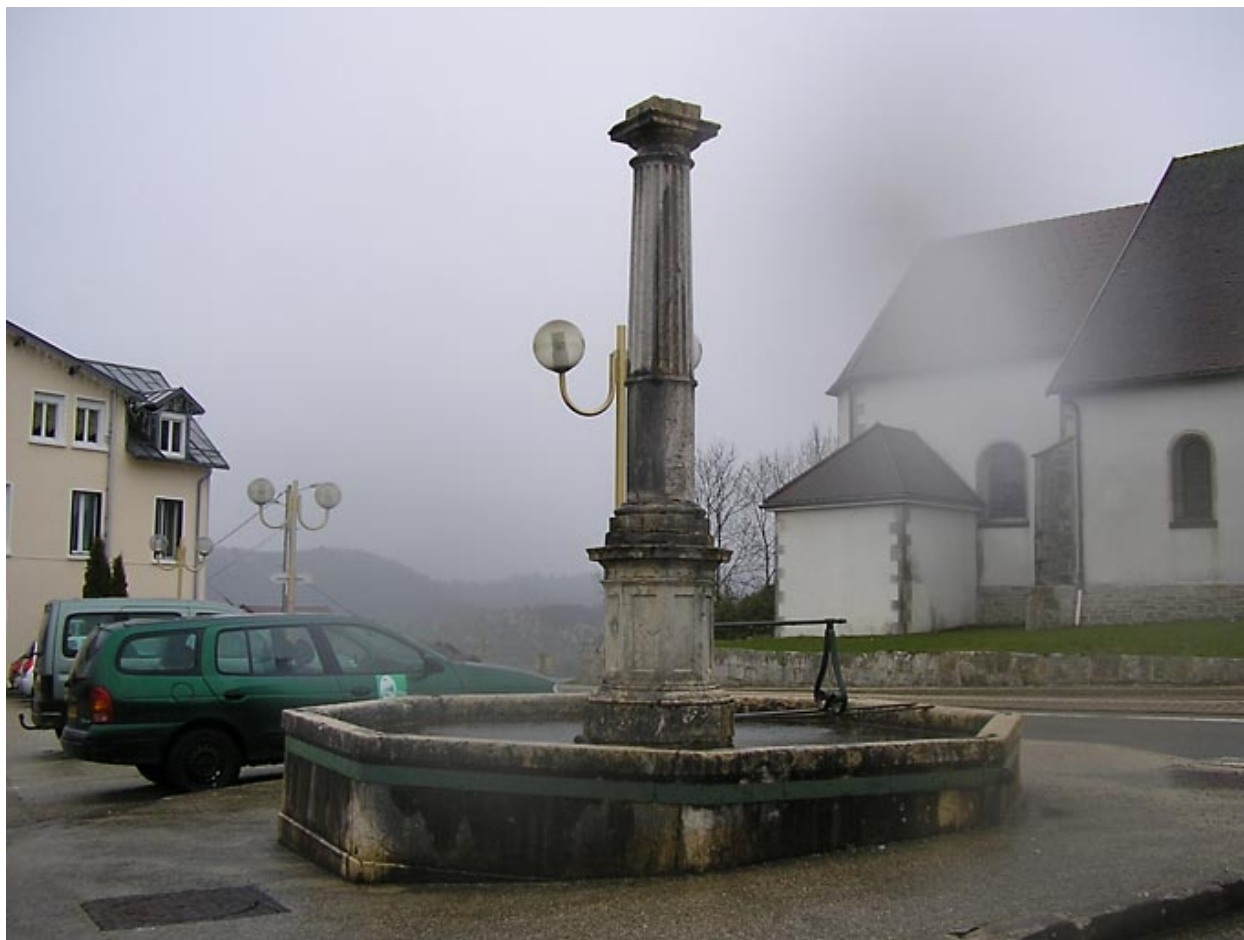
Vue générale sur ensemble hydraulique.
