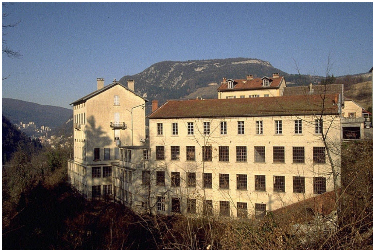
Usine vue du sud.
