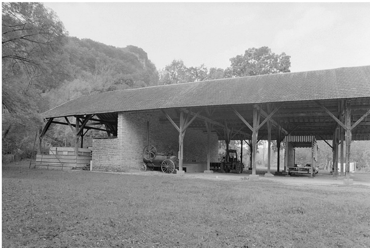
L'entrepôt à merisier.
