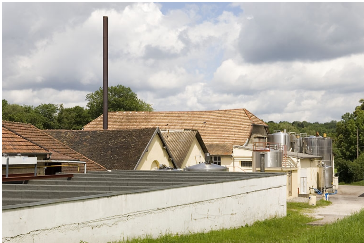
Vue arrière des bâtiments industriels.
