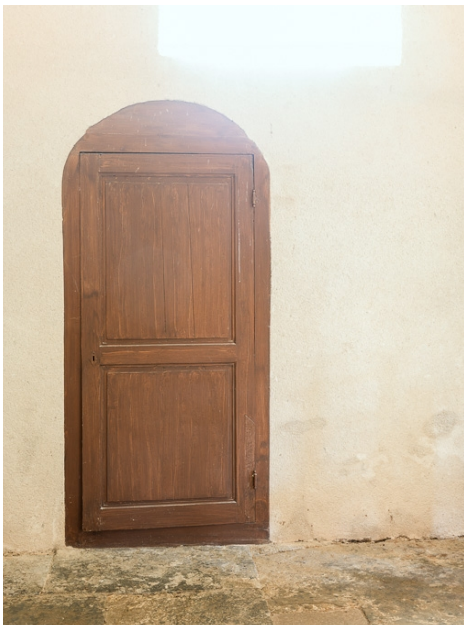
Nef, deuxième travée, élévation sud, porte murée transformée en placard.
