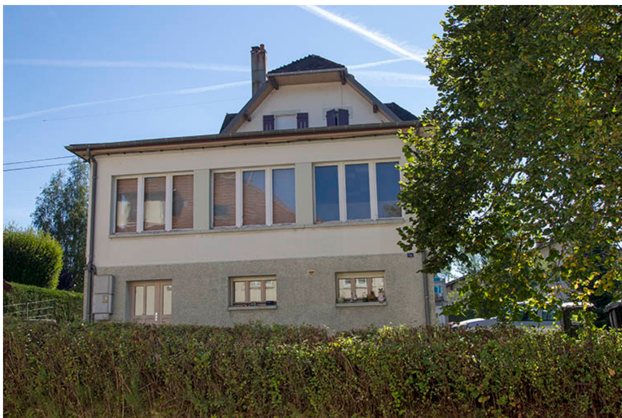
Usine : façade latérale gauche.
