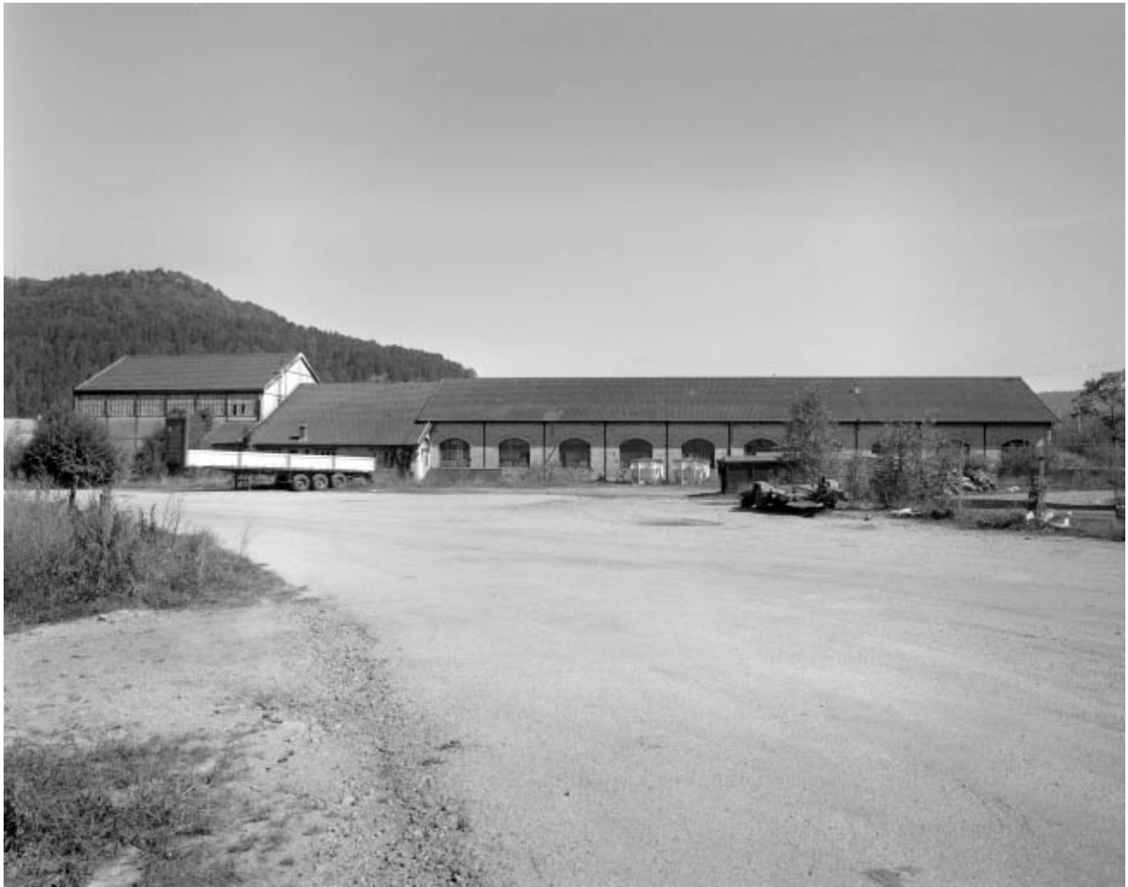
L'atelier de finition depuis l'ouest.
