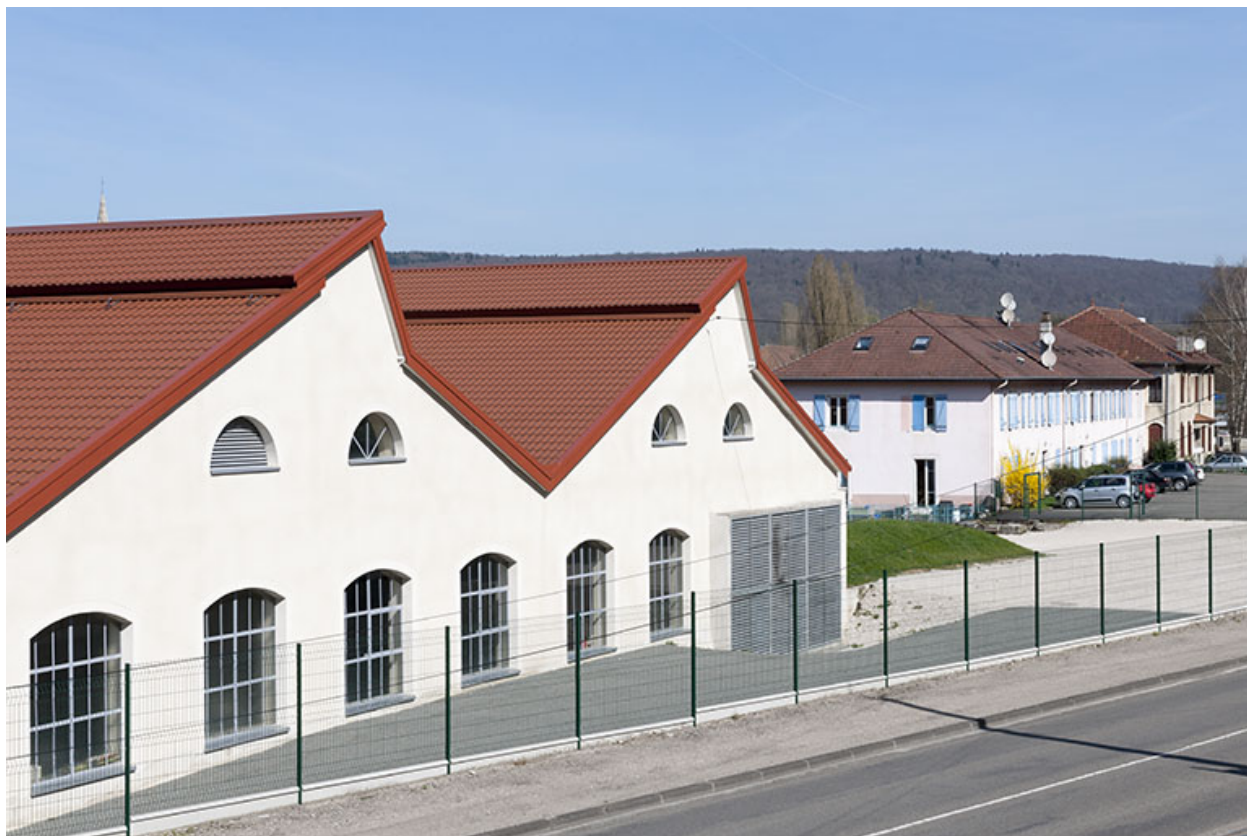
Pignons de la centrale hydroélectrique.
