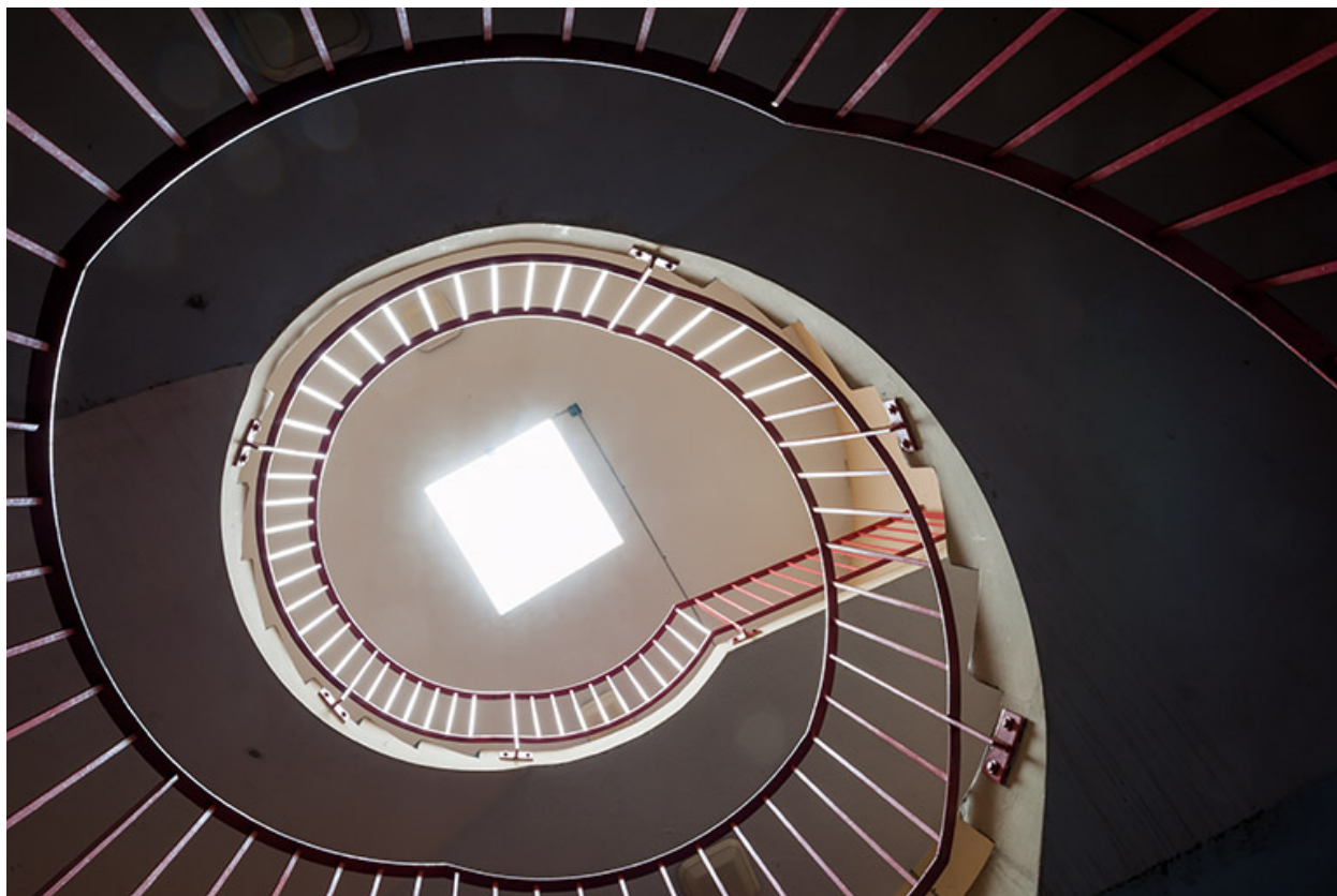
Escalier en vis en béton de l'internat.
