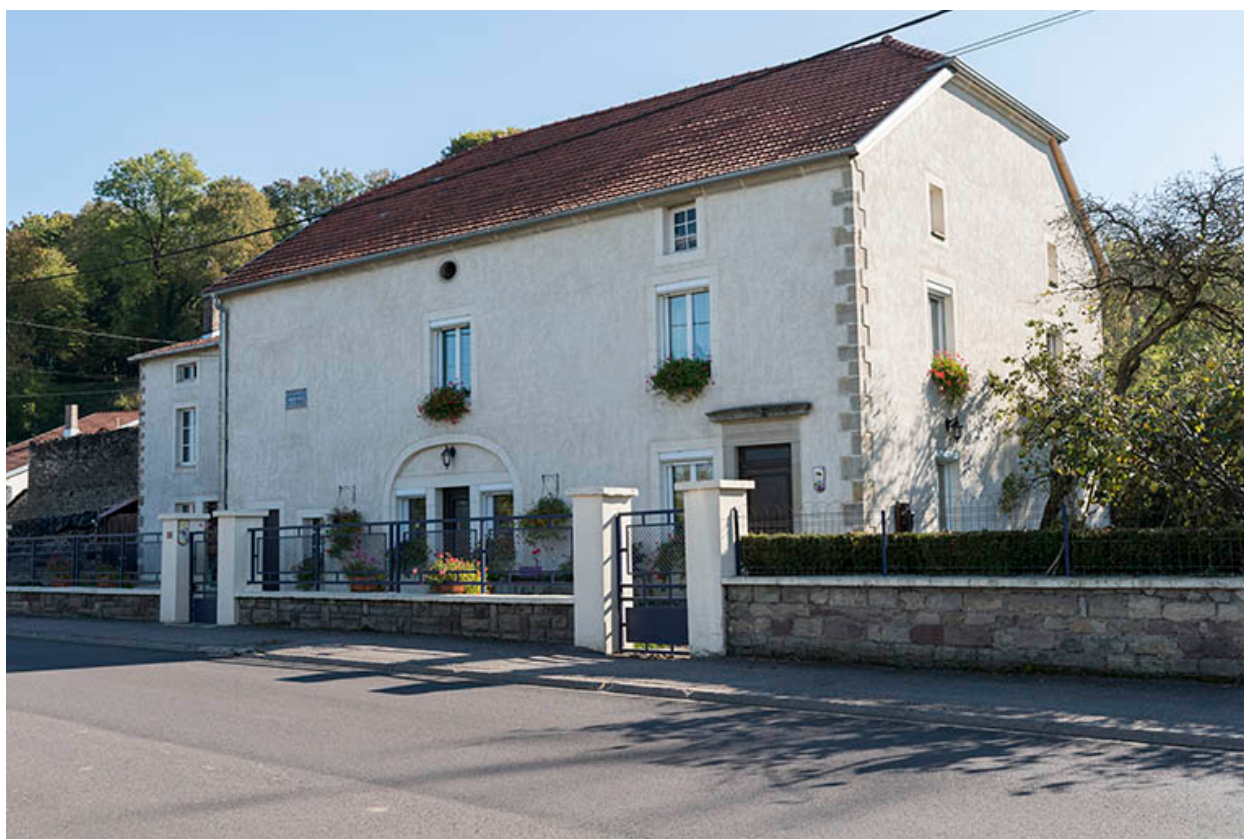
Maison 35, grande rue, vue de trois-quart nord-ouest.
