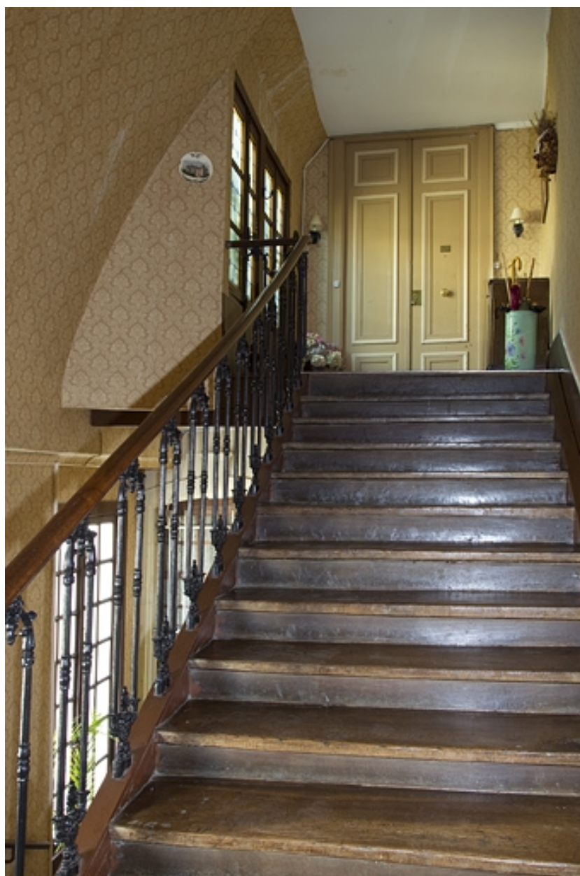
Intérieur de l'escalier : détail d'une volée.
