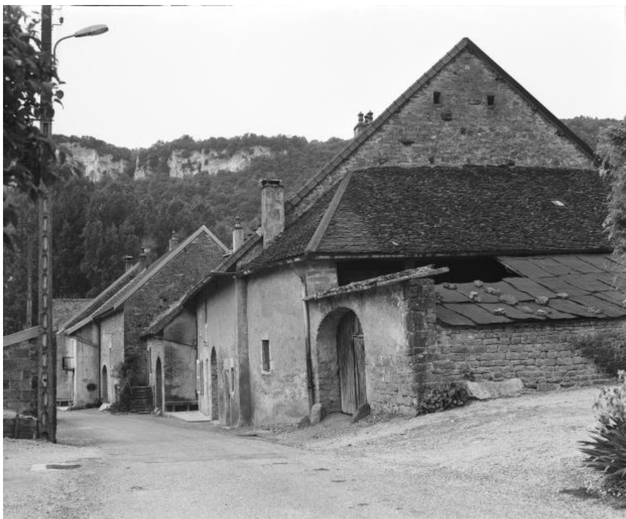
Fermes situées rue du Moulin : vue d'ensemble.
