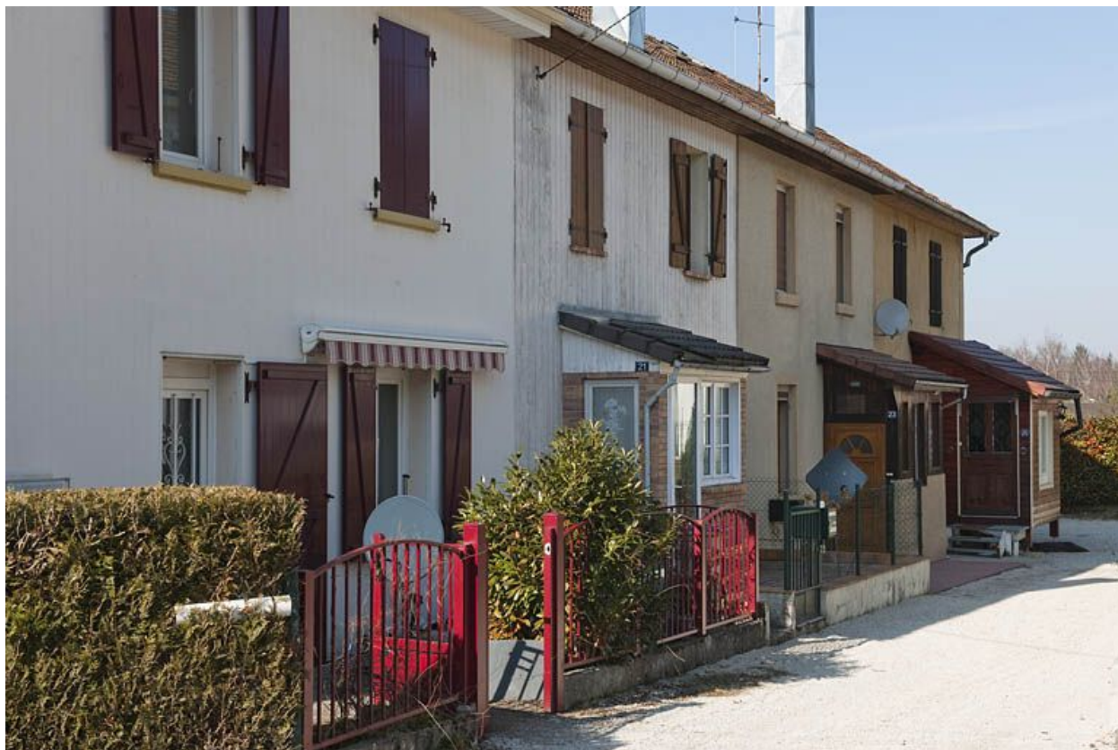
Habitation à 4 logements rue d'Alsace. Façade est.
