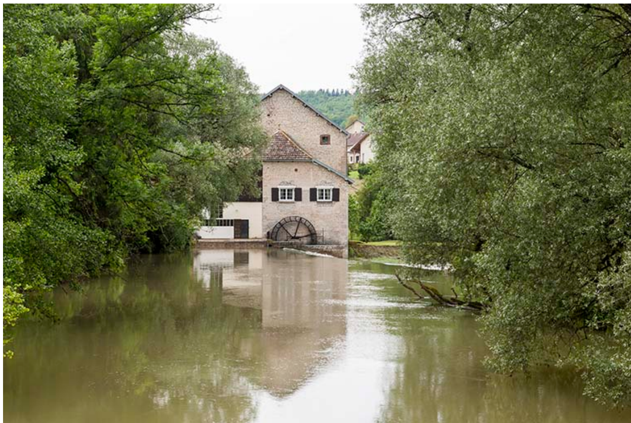
Vue d'ensemble depuis l'amont du Lison.
