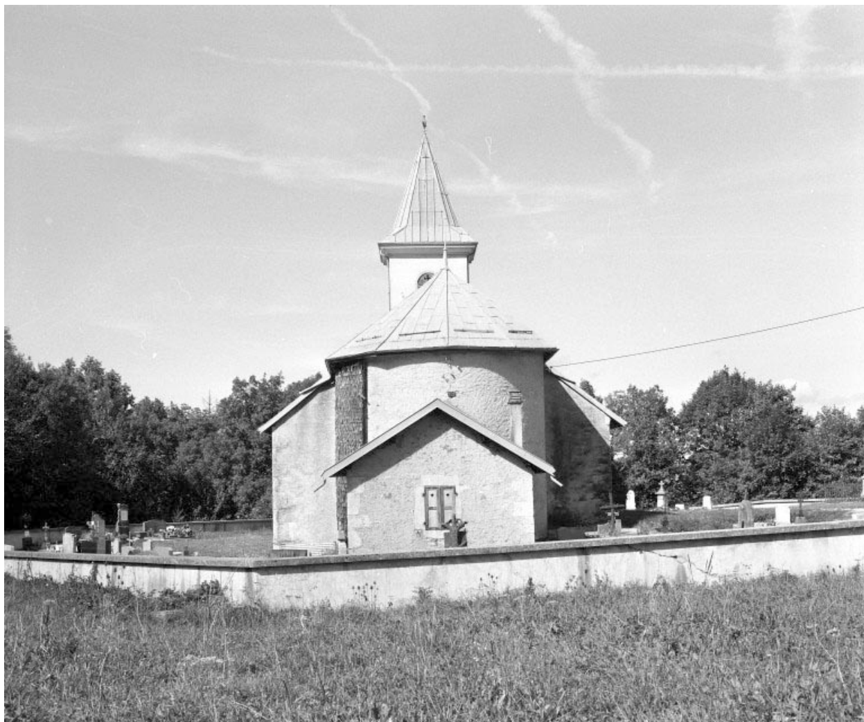
Extérieur : l'abside vue de face.
