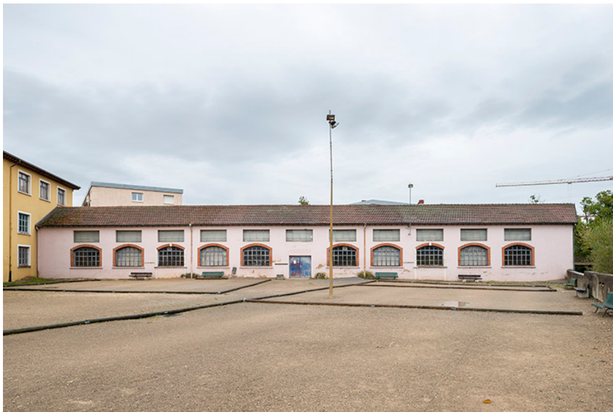
Bâtiment perpendiculaire à l'atelier principal. Façade sud.
