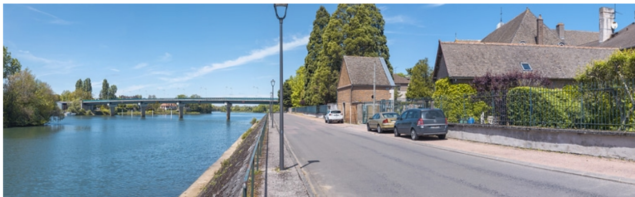
Vue d'ensemble du pont, depuis l'aval.
