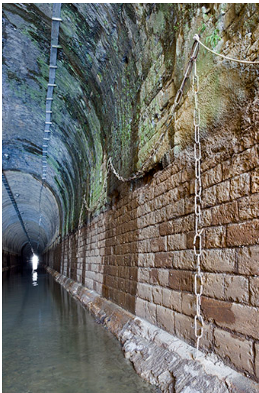
Mur latéral du tunnel maçonné.
