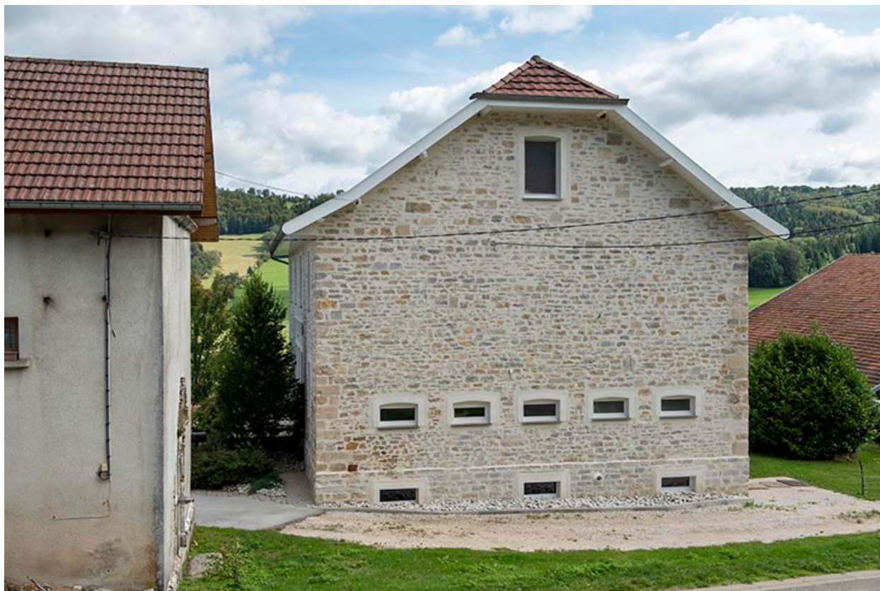
Façade latérale droite.
