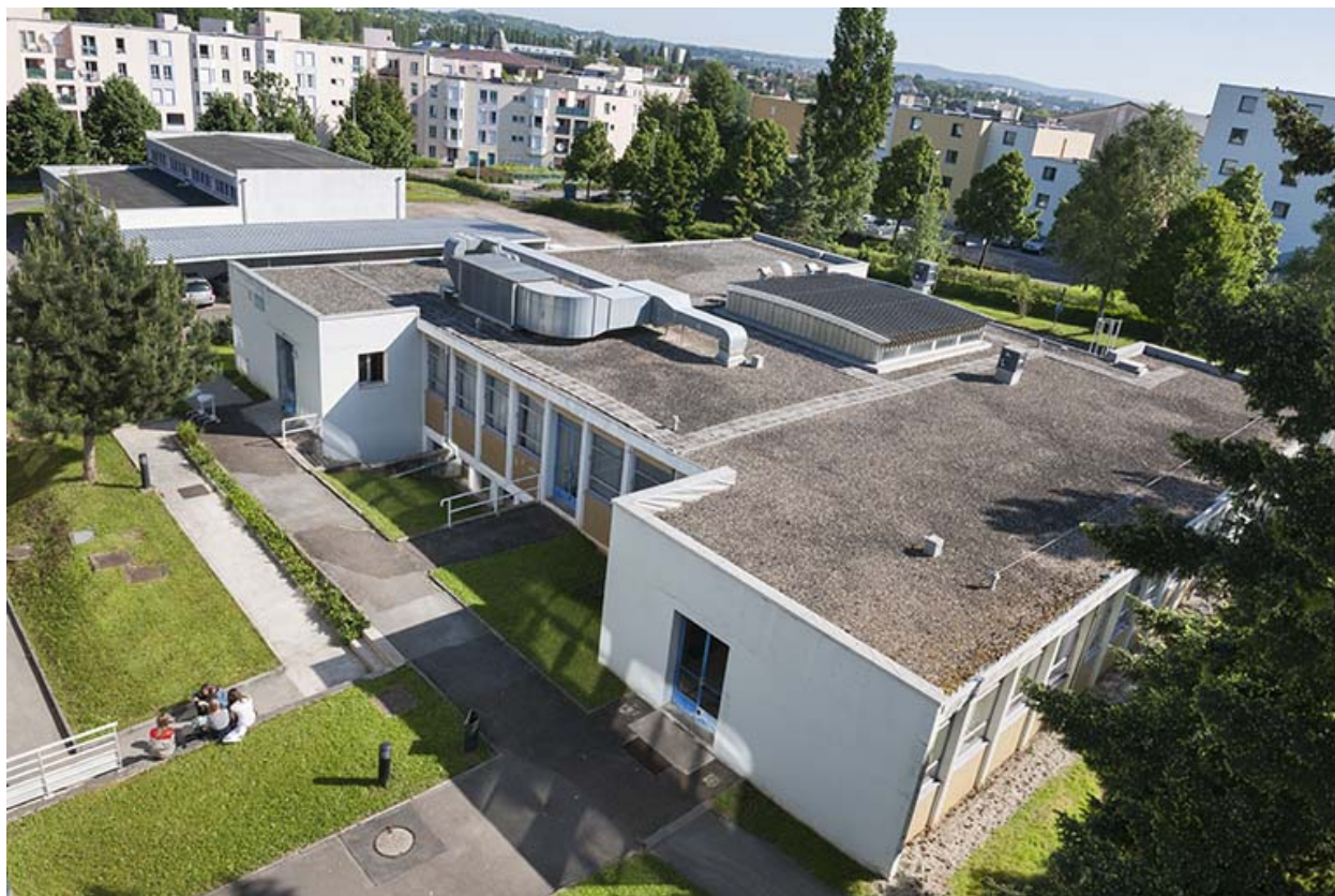
Angle sud-ouest du bâtiment de restauration.
