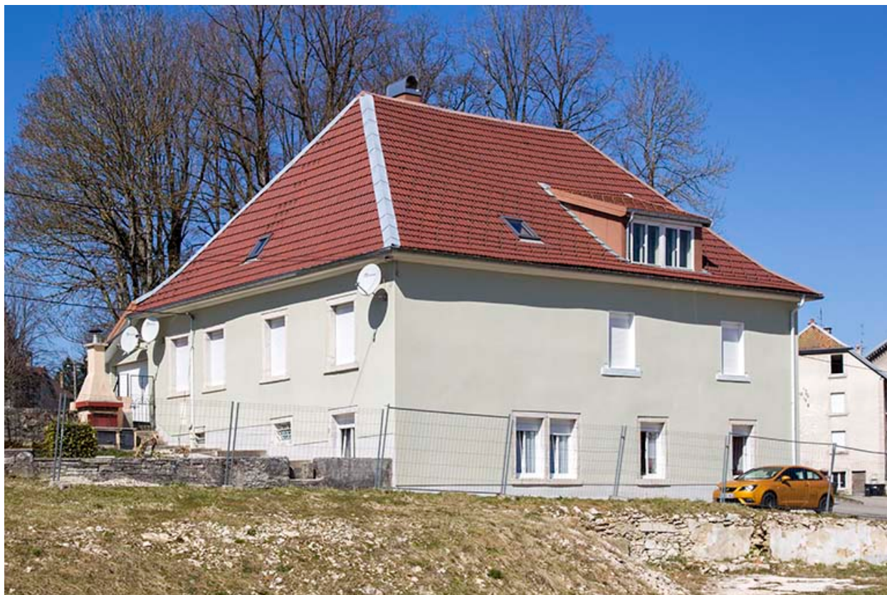
Façades postérieure et latérale droite.
